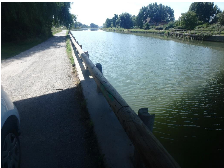
Figure 7 : Site amont de l'Aa à Saint-Momelin
