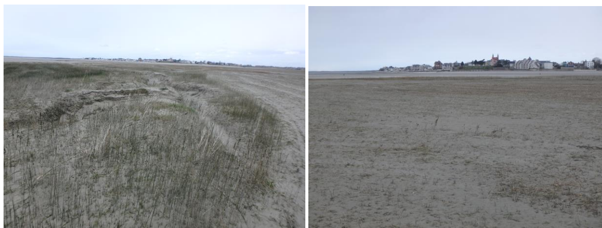
Figure 4 : zone des travaux réalisés au Crotoy en 2020 (illustration du haut) et photographies illustrant la qualité des travaux (illustrations du bas)
