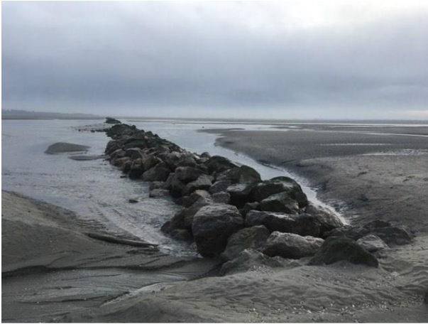
Photographie de la digue Barrois réhaussée à Fort Mahon
