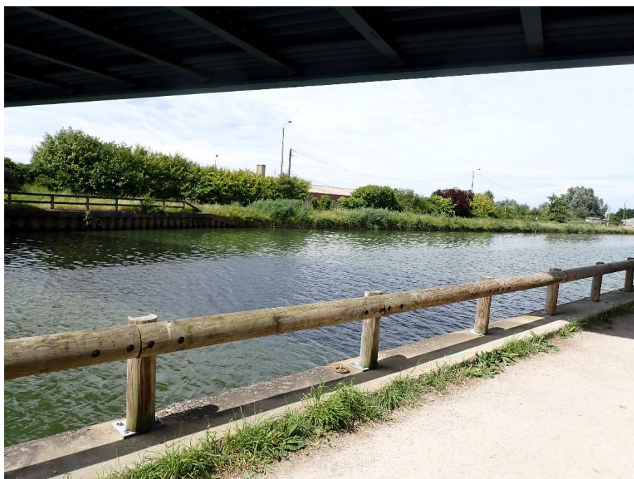
Figure 7 : Site amont de l'Aa à Saint-Momelin
