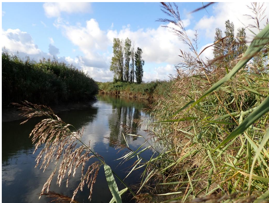
Figure 47 : Site aval du canal à Poissons au Hourdel
