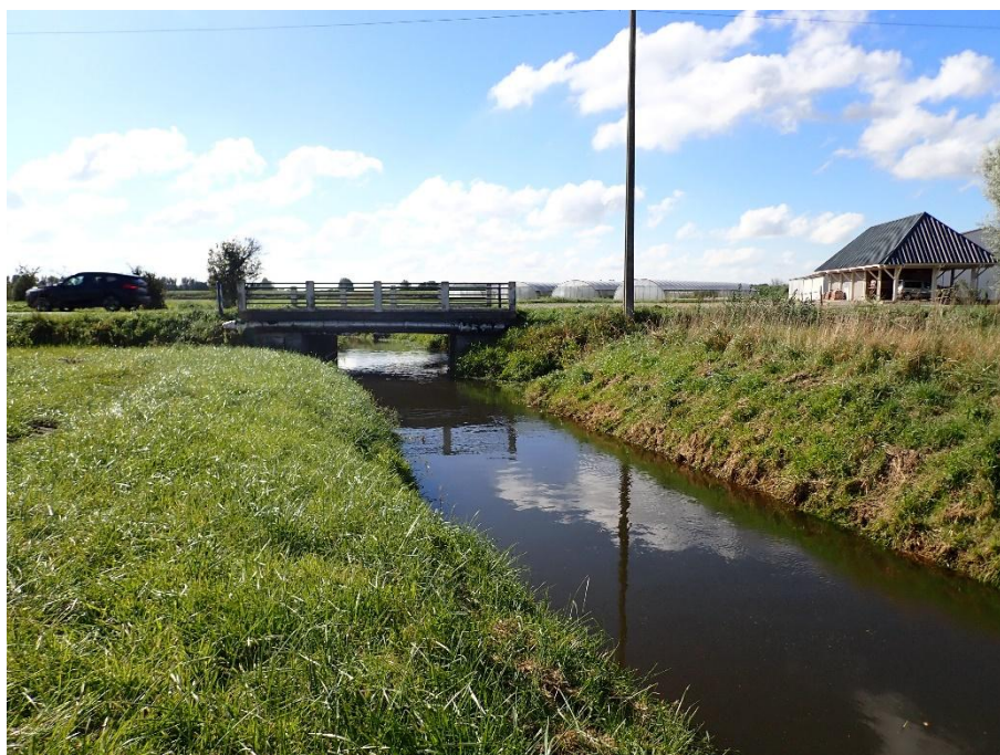
Figure 33 : Site amont du canal de Retz à Monchaux (Quend)
