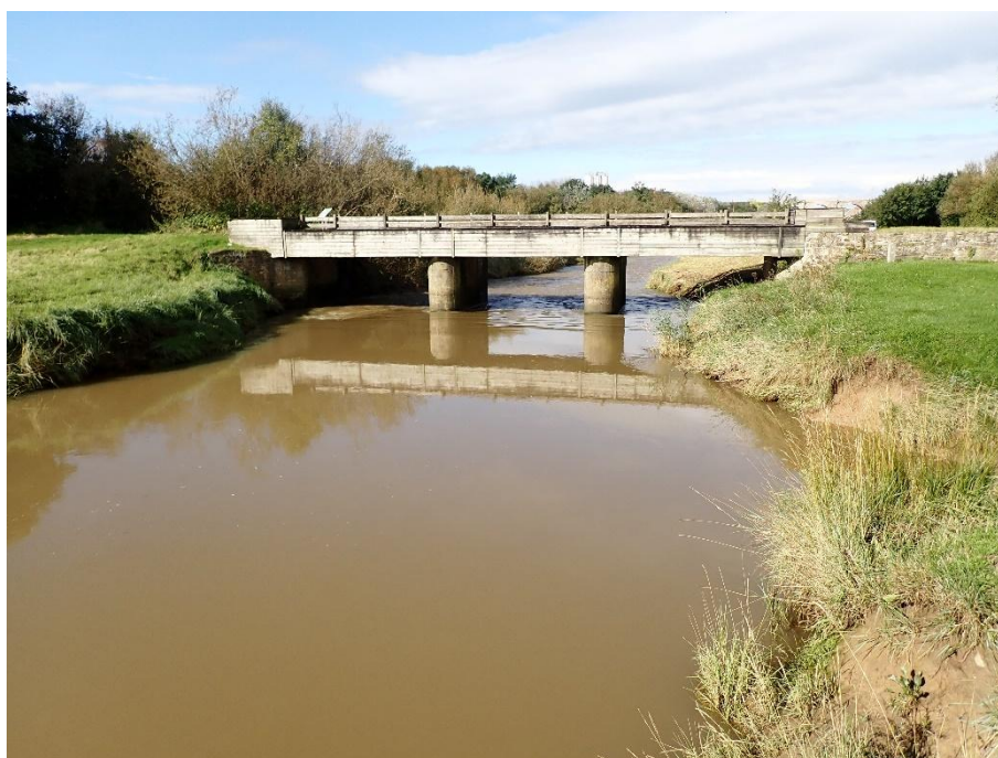
Figure 18 : Site aval du Wimereux à Wimille
