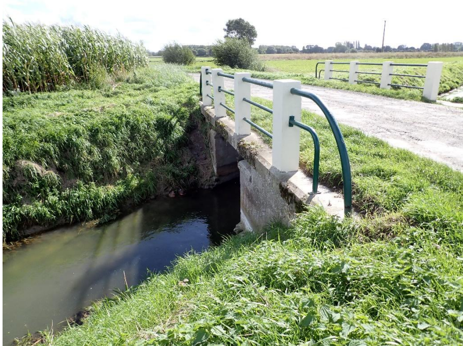
Figure 45 : Site amont du canal à Poissons à Wathiehurt (Lanchères)
